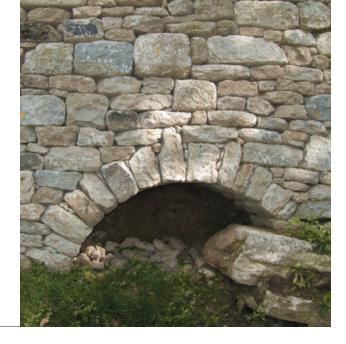
Les murs de soutènement en pierre sèche du château de Lenzbourg, qui se sont dégradés au fil des ans, nécessitaient une rénovation professionnelle. Le matériau existant fut soigneusement trié avant d'être réutilisé.
